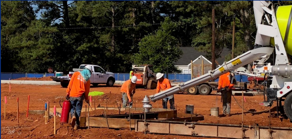
Curb and Gutter Concrete Pour
